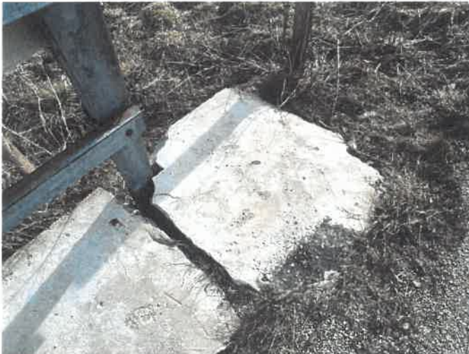
Eclat du béton au droit du scellement du montant d'extrémité rive droite
