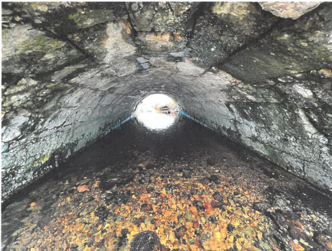
Vue d'ensemble de la voûte depuis l'amont
