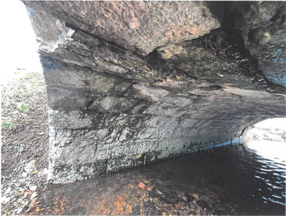
Eclat des pierres gélives et décollement du bandeau amont côté rive gauche
