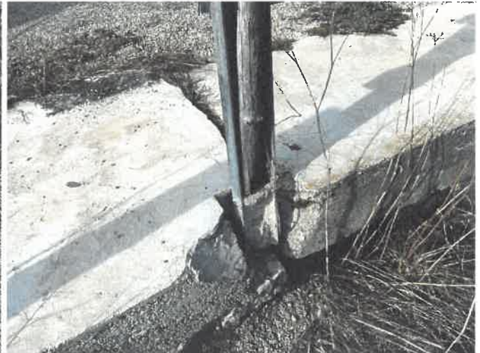
Eclat du béton au droit du scellement du montant d'extrémité rive droite
