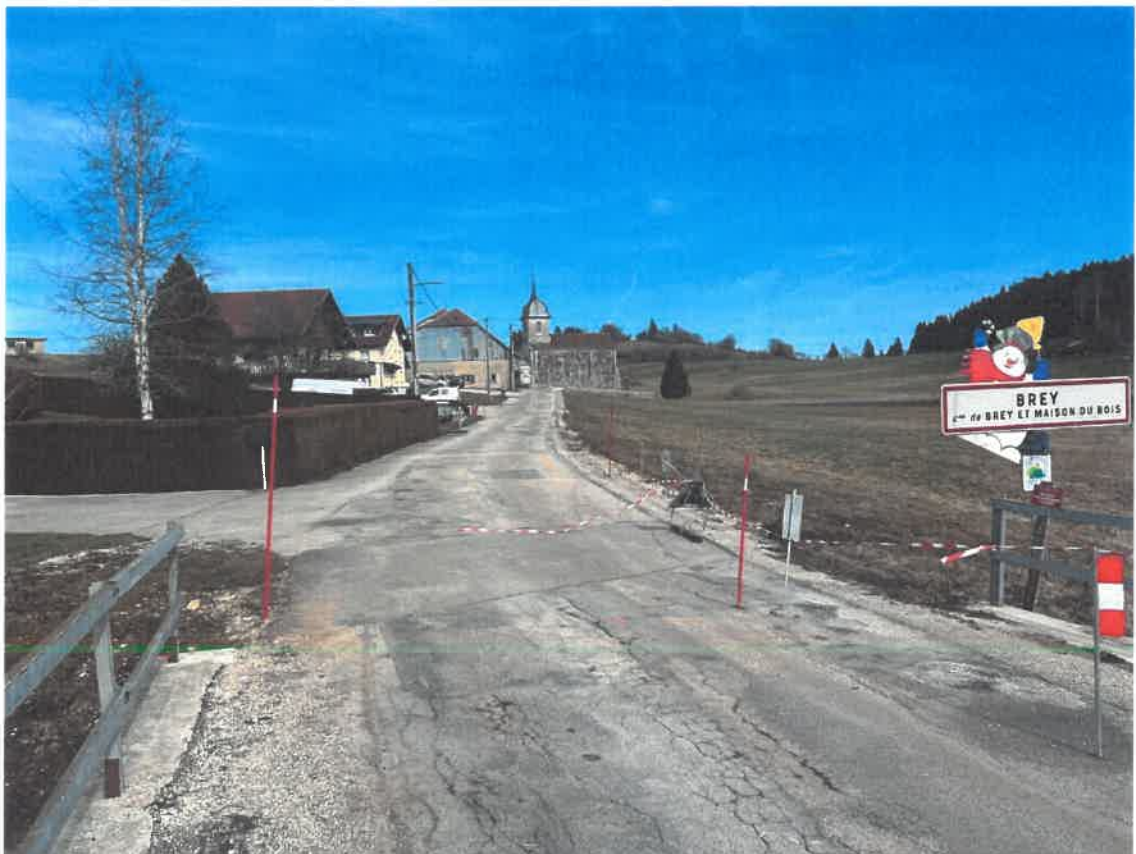
Environnement rive gauche en direction du centre du village
