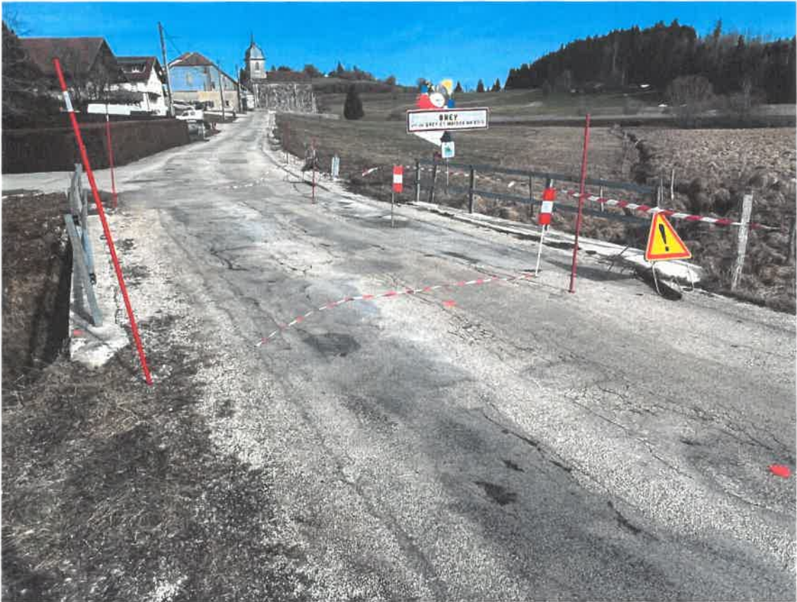
Vue d'ensemble de la chaussée sur l'ouvrage depuis la rive droite
