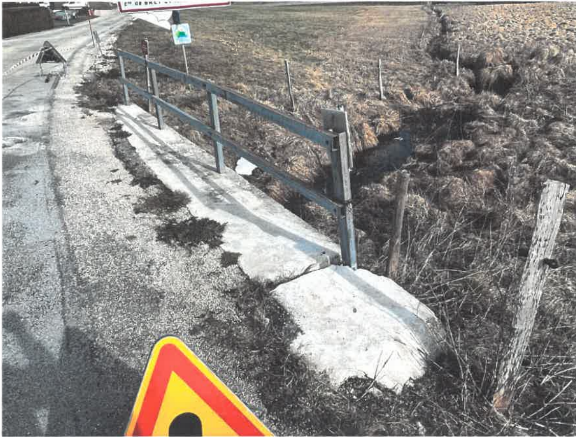
accotement aval depuis la rive droite déformation du garde-corps à la suite d'un choc de véhicule et à un défaut des scellement des montants
