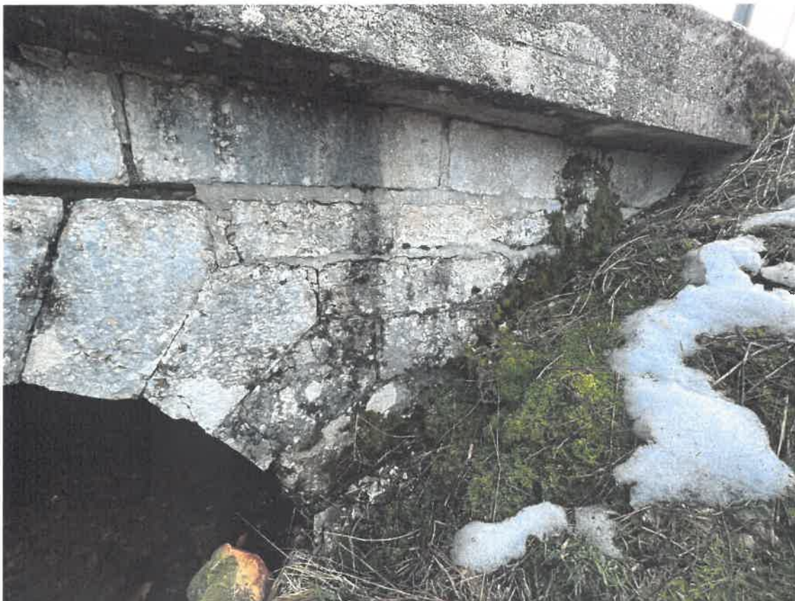
Eclat des pierres gélives du tympan et du bandeau amont / rive droite
