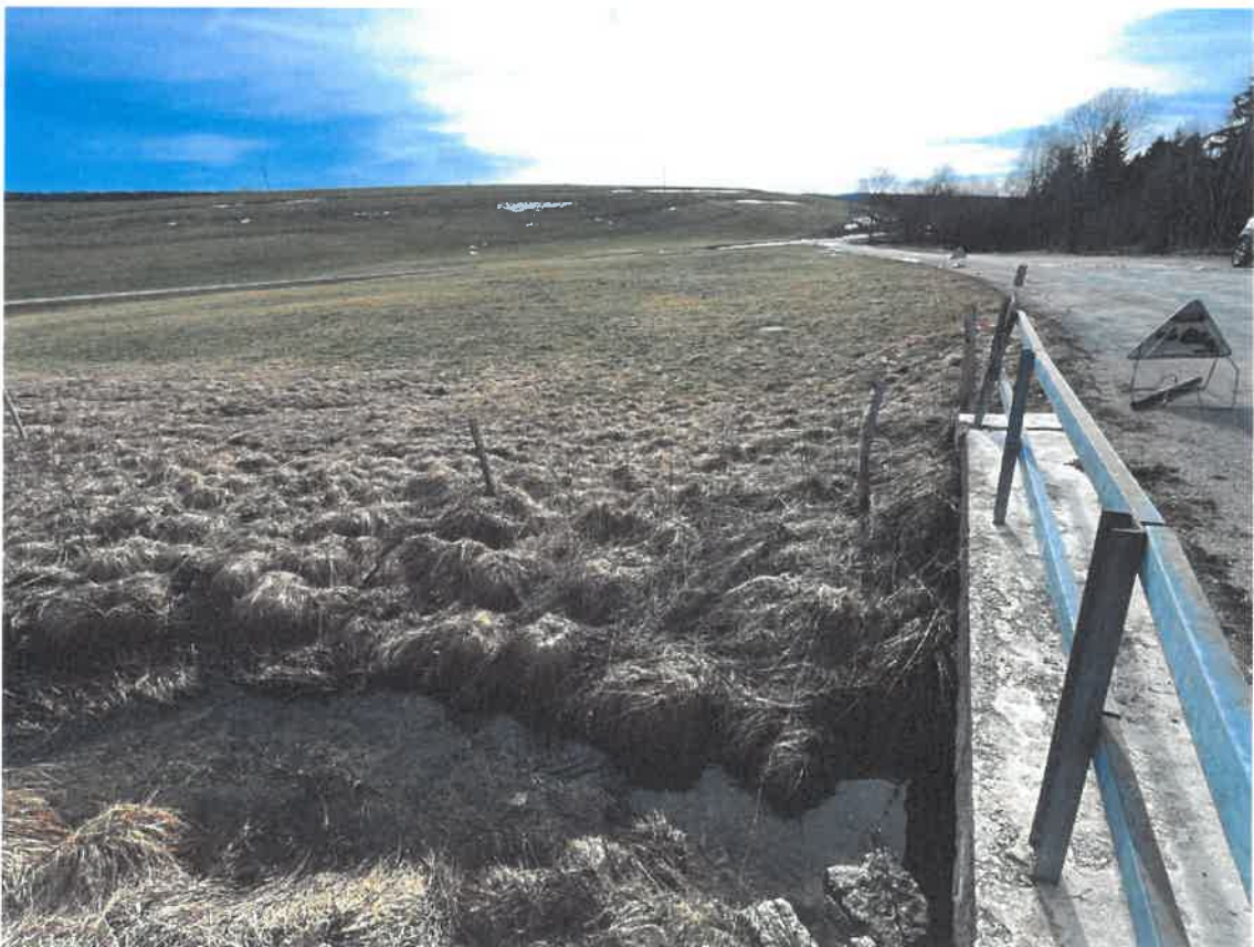
Environnement aval rive droite
